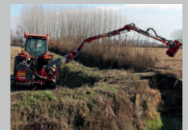
DPS 1100 en phase travaux
