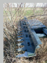
TA 160 en phase travaux
